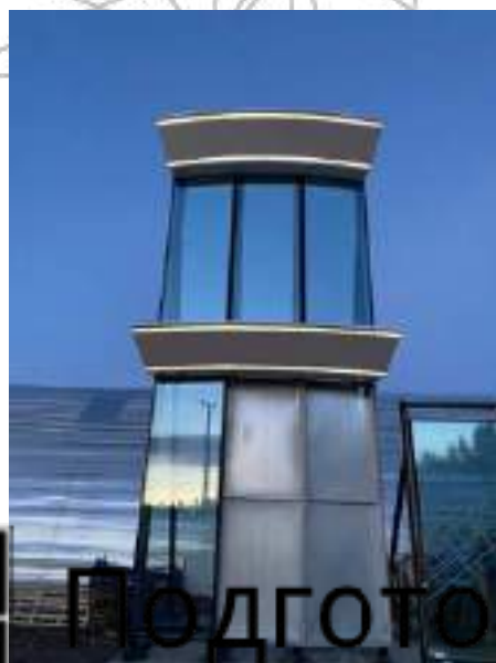
Mock-Up (Mock-Ups) - фрагмент фасада здания
