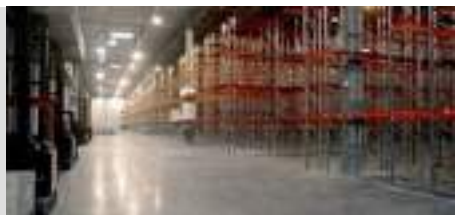
Бетон с упрочнённым верхнем слоем
